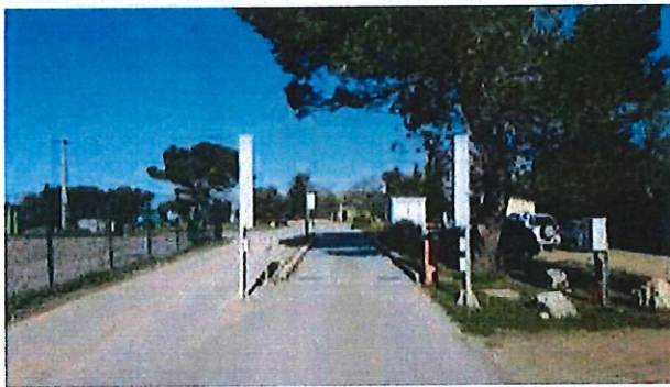
Figure 15 : Pont bascule et portique de détection (Source : SMZV)
